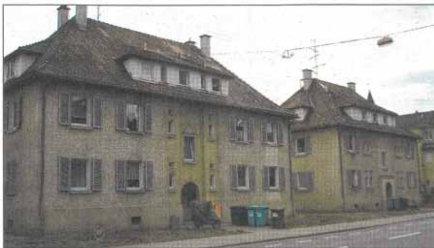
Diese Häuser in der Darmstädter Landstraße sollen in diesem Jahr saniert werden. FOTO: SABINE DINGELDEIN
