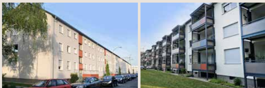
Bestandsobjekte „Robert-Koch-Straße 3-11“ und „Dr.-Kitz-Straße 29“ im Stadtteil Gustavsburg
