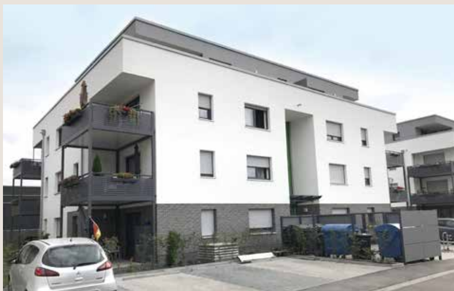
Neubau „K3 Am Alten Sportplatz“, Stadtteil Ginsheim
