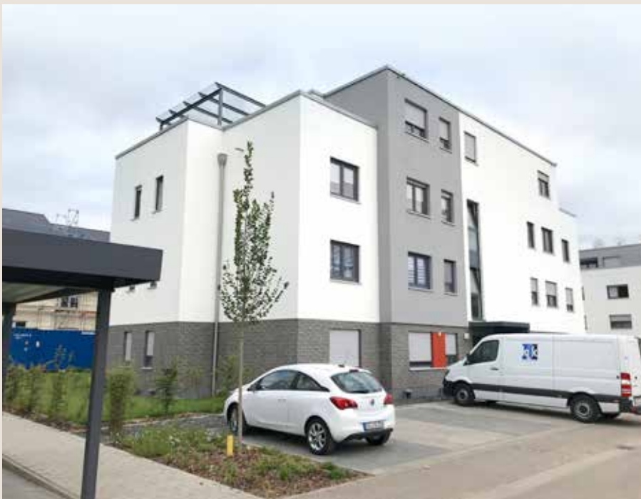
Neubau „J2 Am Alten Sportplatz“, Stadtteil Ginsheim
